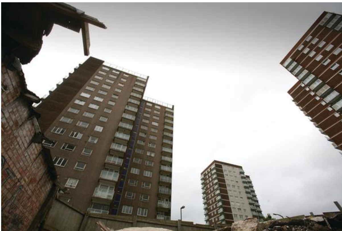
Figura 13 – Sui tetti dei tower block trovavano spazio ingegni particolari con antenne fai da te, in grado di diffondere quanto trasmesso dalle radio pirata.
